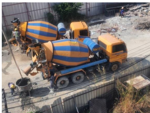
ภาพที่ 2.2-12 รถคอนกรีตผสมสำเร็จ/เครื่องมือก่อสร้างใช้ไฟฟ้า
