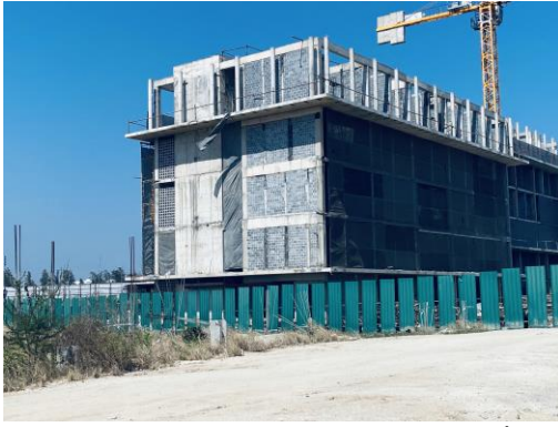
ภาพที่ 2.2-1 (ต่อ) ล้อมรั้ว Metal Sheet บริเวณพื้นที่ก่อสร้าง
