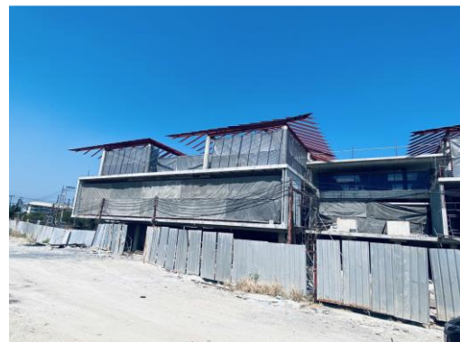
ภาพที่ 2.2-2 ฝ้าใบก่อสร้าง (Mesh Sheet)
