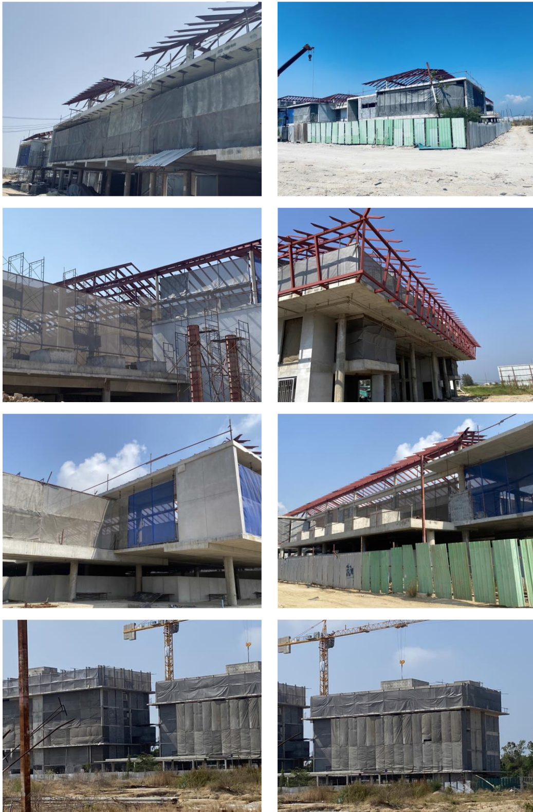
ภาพที่ 2.2-2 (ต่อ) ผ้าใบก่อสร้าง (Mesh Sheet)
