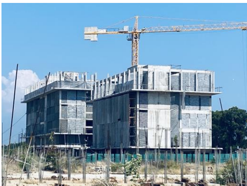
ภาพที่ 2.2-2 ฝ้าใบก่อสร้าง (Mesh Sheet)
