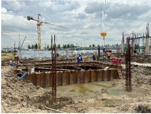
ภาพที่ 2.2-32 Sheet Pile ป้องกันการพังทลาย
